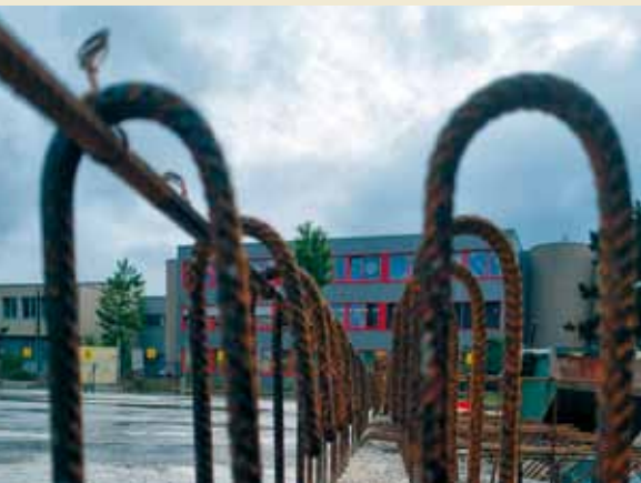
Spezielle Sicht durch die Bewehrungsstäbe
