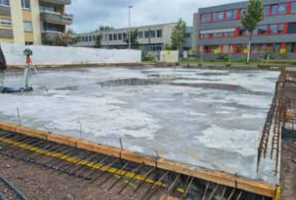
Betonierung Bodenplatte
