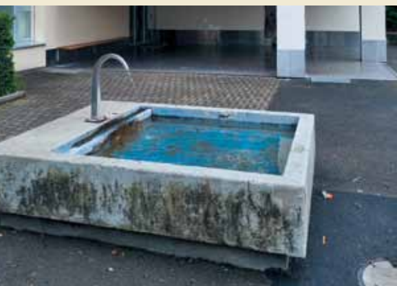
Der Brunnen wird ersetzt
