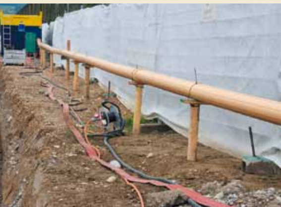
So geht Bauen in der Grundwasserschutzzone!
