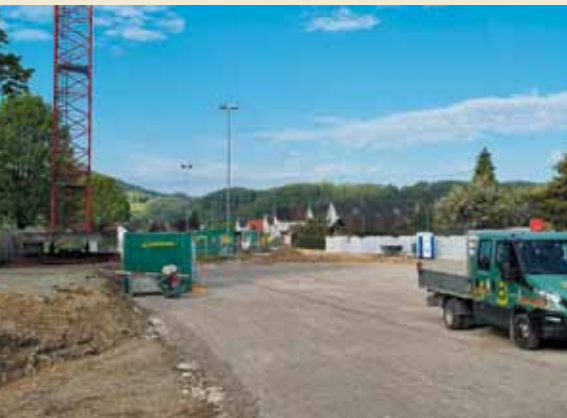
Baustellensituation, Stand 23. April 2025
